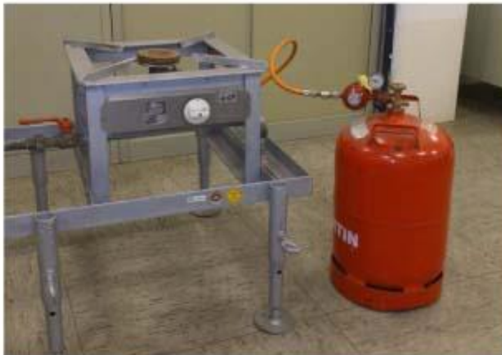
Abb. 9: Verbrauchseinrichtung mit Flüssiggasflasche
